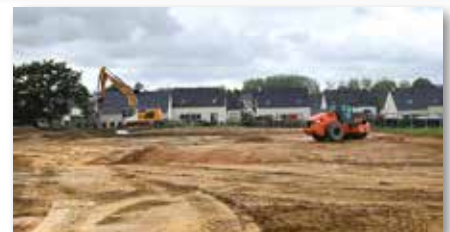
Démarriage des travaux sur le site des Blancherais
