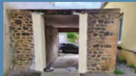
L'ouverture faite dans le garage pour l'accès PMR à la cour intérieure par le monte-personne prochainement installé
