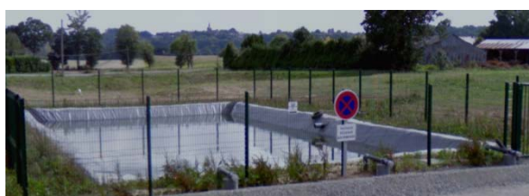
Bassin de rétention d'eau présent à l'Est de l'aire d'étude
